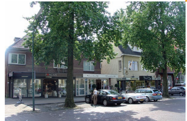
aaneengesloten winkelrouting aan de Julianalaan
