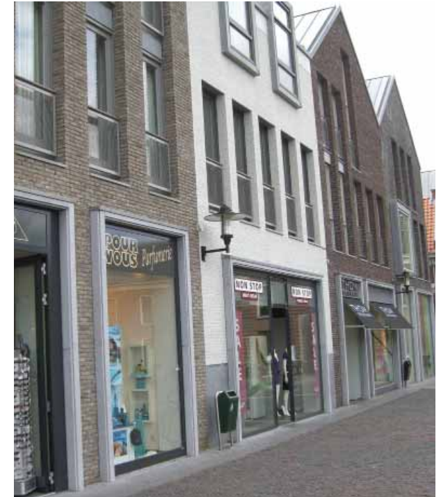
door parcelering sluit de schaal van de bebouwing aan op het dorpse karakter van Bilthoven, door de toepassing van (opliggende) kozijnen met een diepe negge ontstaat variatie in het gevelbeeld (c)
