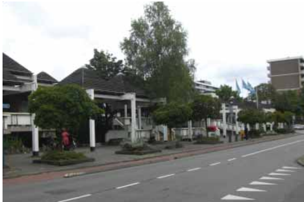
voorbeeld uit Bilthoven: de bestaande hoofdentree van De Kwinkelier aan de Sperwerlaan
