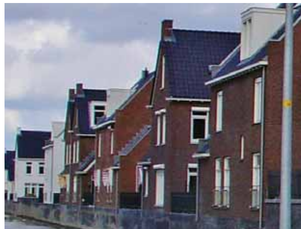
variatie in de bebouwing wordt onder meer verkregen door wisselende bouwhoogtes, kapvormen en kaprichtingen
