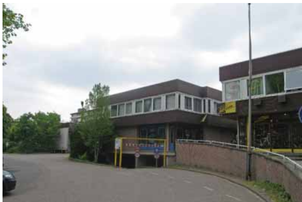
voorbeeld uit Bilthoven: de bestaande auto-entree van De Kwinkelier aan de zijde van de Spreeuwlaan
