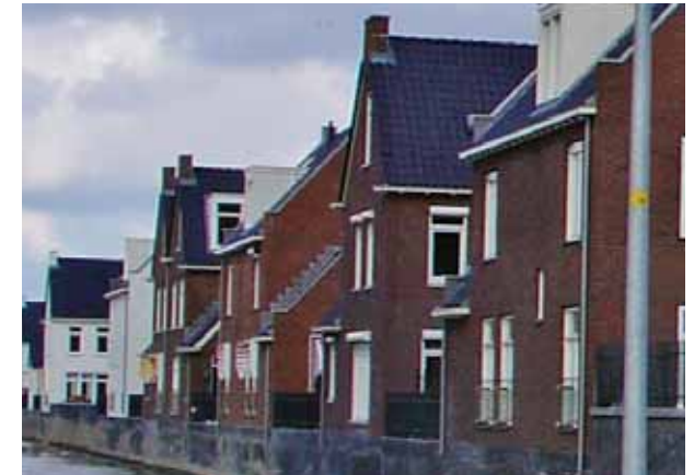
de panden aan de Vinkenlaan en de Nachtegaallaan staan op een verstaffelde of versprongen rooilijn
