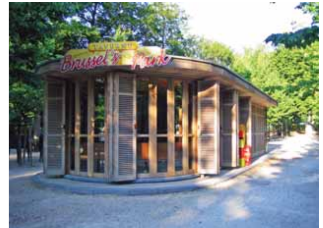
op het vernieuwde Vinkenplein komt bij voorkeur een nieuw bijzonder gebouw in de vorm van een kiosk, paviljoen of folly
