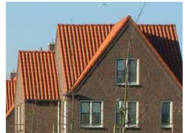
samengestelde kappen vormen een veelgebruikt thema in de Julianalaan
