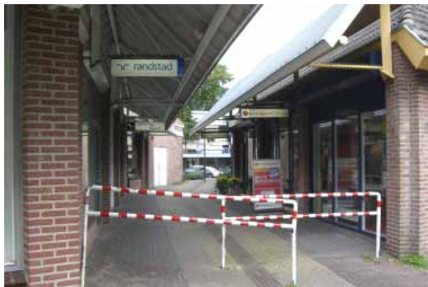
voorbeeld uit Bilthoven: de entree aan de zijde van de Julianalaan is niet uitnodigend
